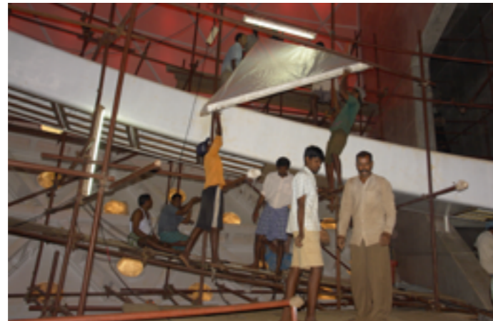
1996 war die erste Schicht der Außenhaut mit vorgefertigten Ferrozement-Platten verkleidet
