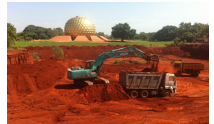
2009 wurde mit den Gartenarbeiten begonnen, zunächst mit den Wegen im „Garden of Unity“ und dem zentralen Brunnen
